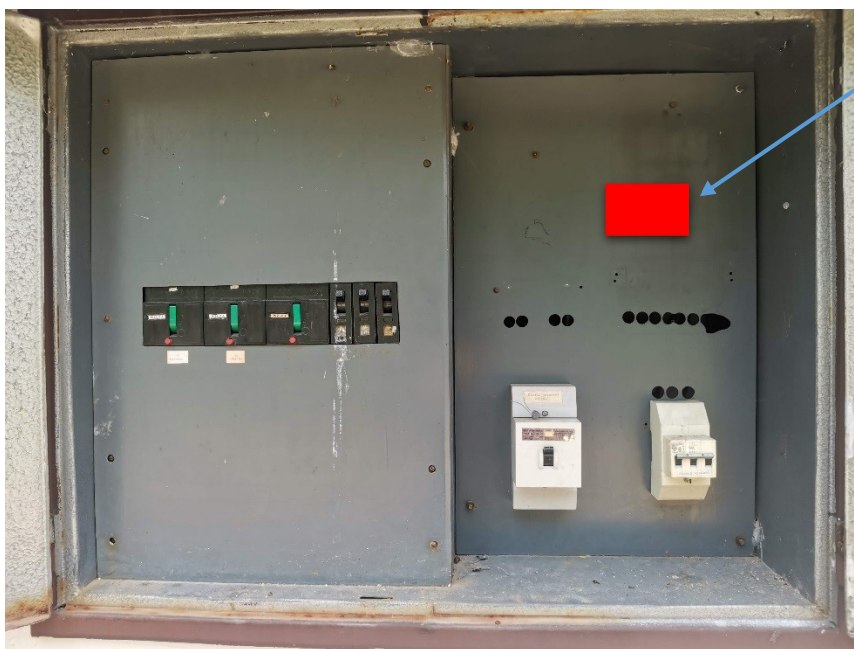
Elektroměrový rozvaděč RE na fasádě
