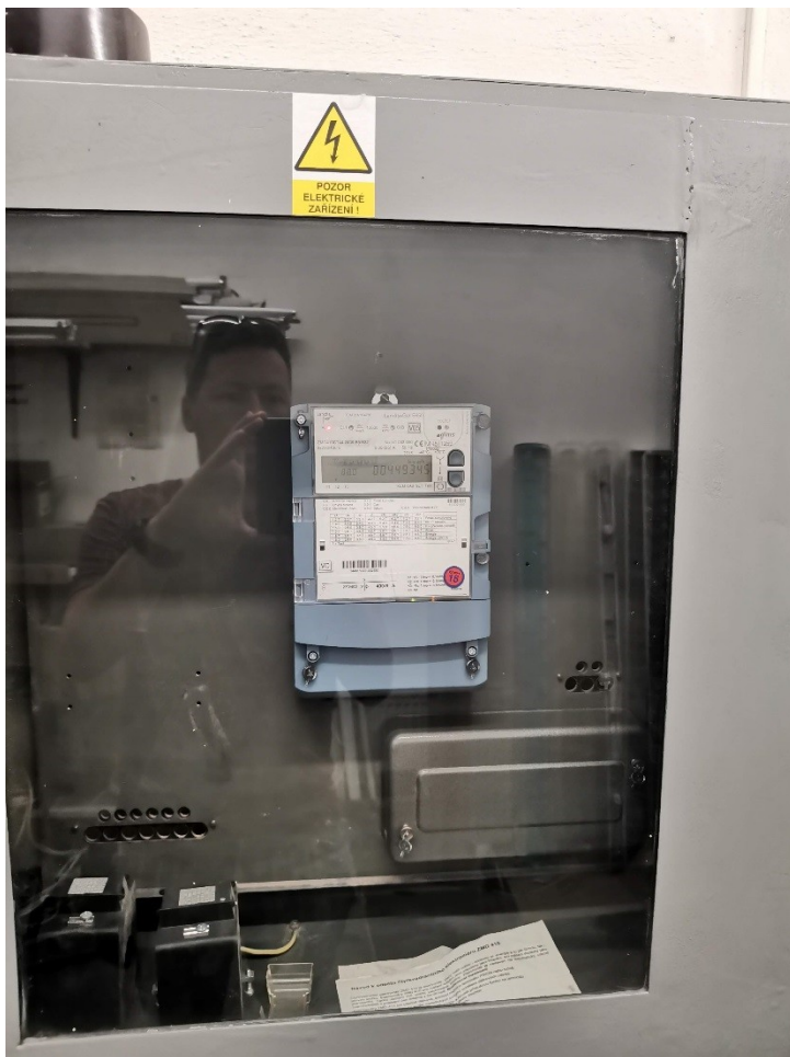
Elektroměrový rozvaděč RE
