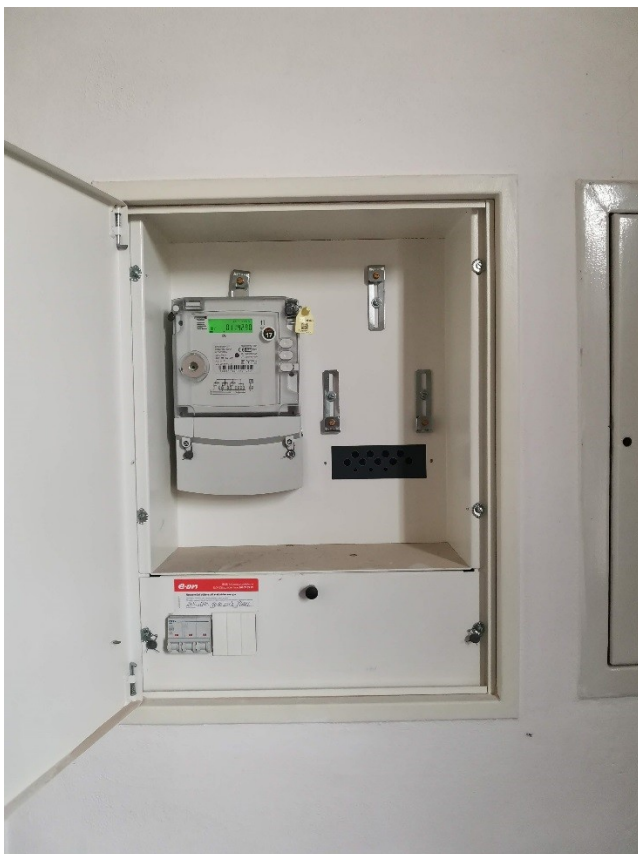
Elektroměrový rozvaděč RE
