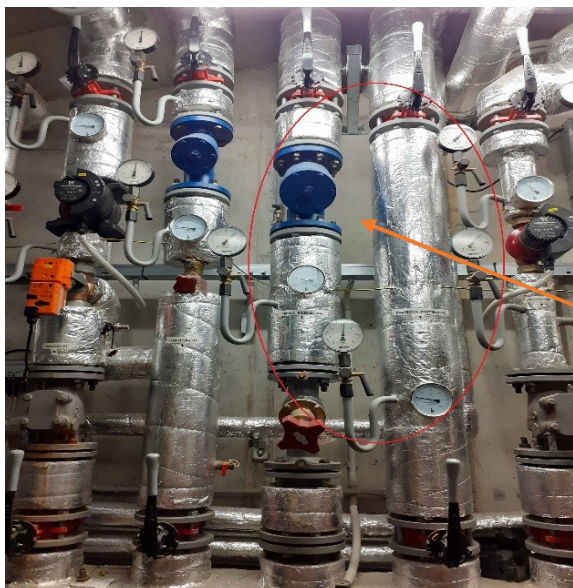
OPS pro B2: návrh měření UT + TV
